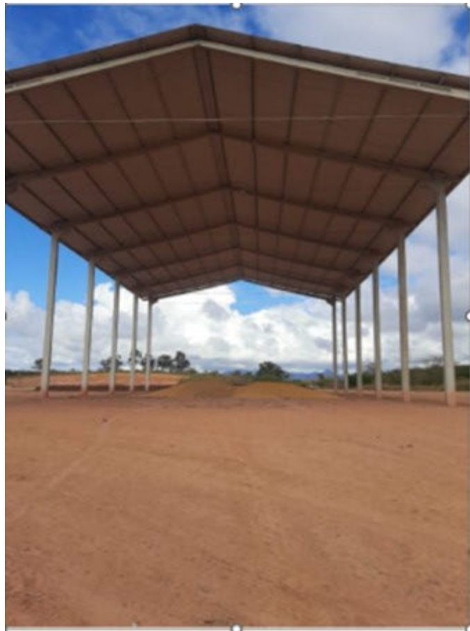
Galpão existente totalizando 900 m 2
