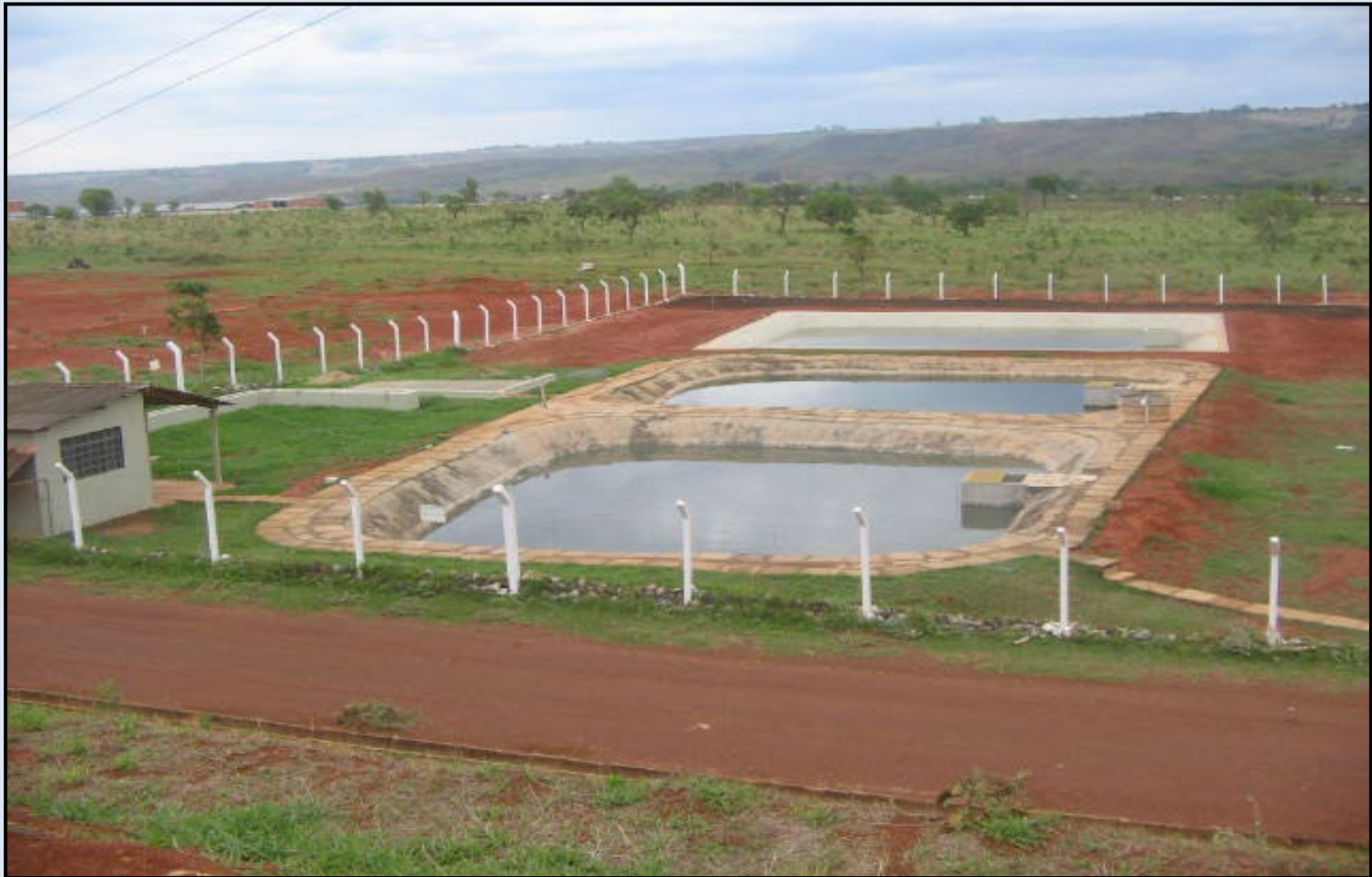
Vista da unidade experimental situada na ETE Samambaia - DF
