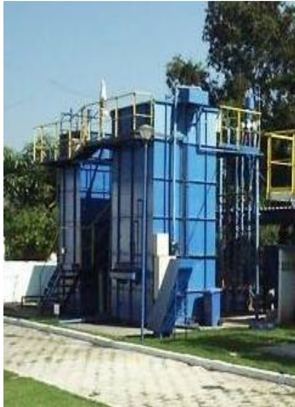
UASB seguido de Biofiltro Aeróbio (UFES)
