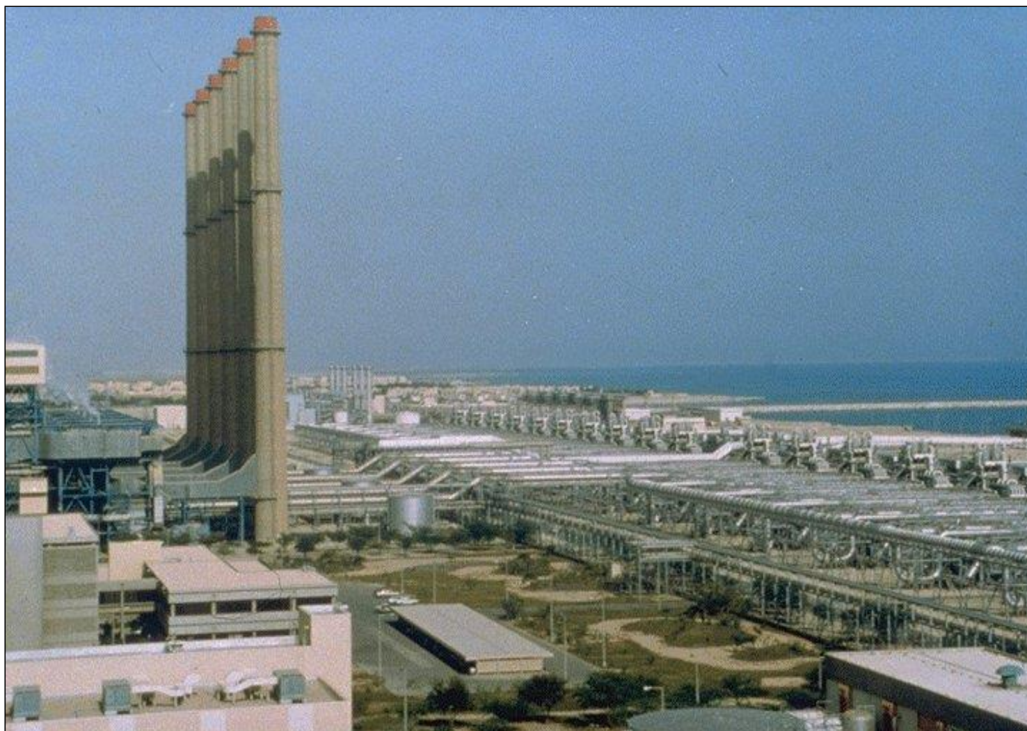
Usina de dessalinização em Jubail (Arábia Saudita)
