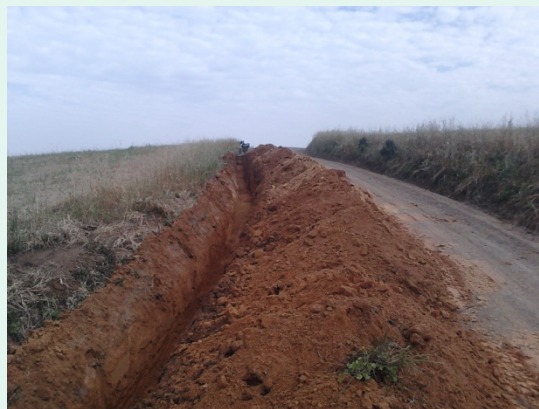
Abertura das valas com apoio da Comunidade para assentamento das tubulações
