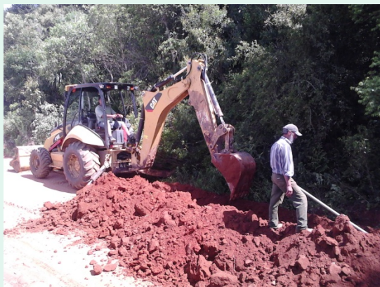
Abertura das valas com apoio da Comunidade para assentamento das tubulações
