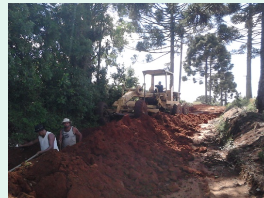
Abertura das valas com apoio da Comunidade para assentamento das tubulações
