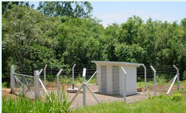
Casa de Tratamento
