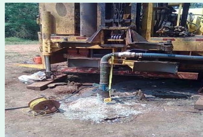
ARARUNA – Colônia Upa Poço: 49m 3 /h - 106 ligações – 36.236m de Rede
