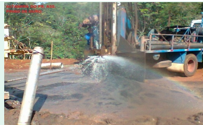
ALTAMIRA DO PARANÁ – Pingo de Ouro Poço: 2m 3 /h – 25 ligações – 10.500m de Rede
