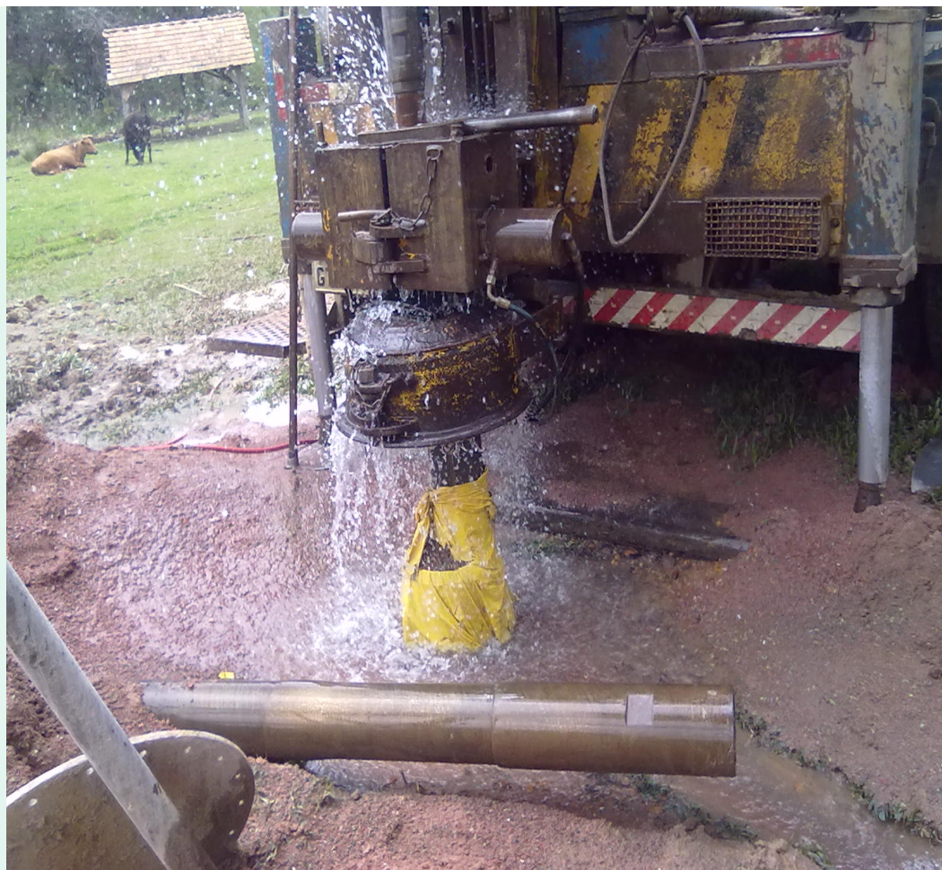
AGUDOS DO SUL – Tarumã Poço: 5m 3 /h - 90 ligações – 8.298m de Rede
