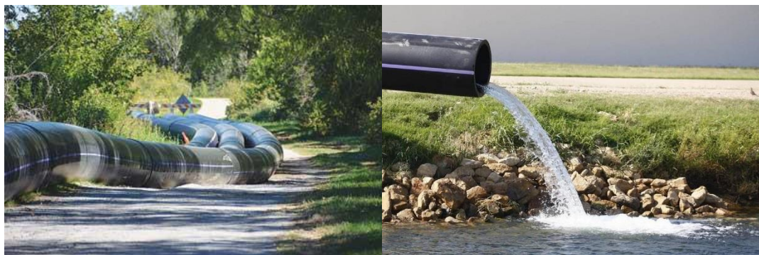
Figura 16 – Instalações Emergenciais em Wichita Falls, TX
